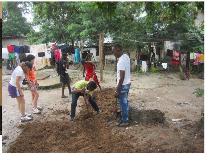
Verbesserungsarbeiten an der Wasserleitung
