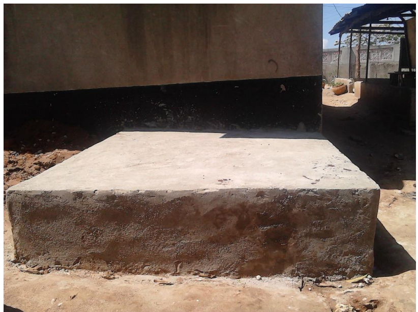
Das neue Fundament hinter dem Jungenschlafsaal
